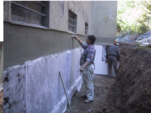
Stoßfeste Sockelabdichtung...
