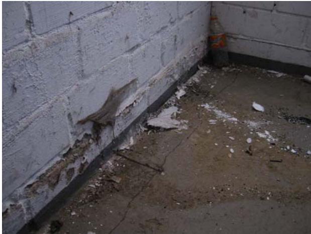
Feuchtigkeitsschäden innen...
