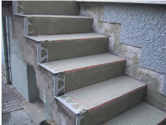
Erstellung der neuen Abdichtung unter den Fliesen
