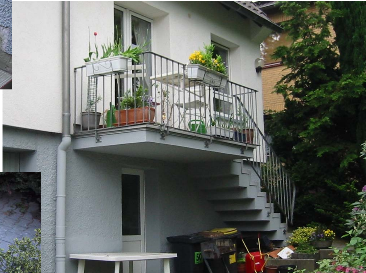
mit Randaufkantung zur Verhinderung neuer Wasserlaufspuren
