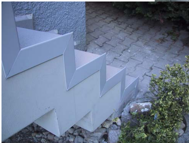
mit Randaufkantung zur Verhinderung neuer Wasserlaufspuren
